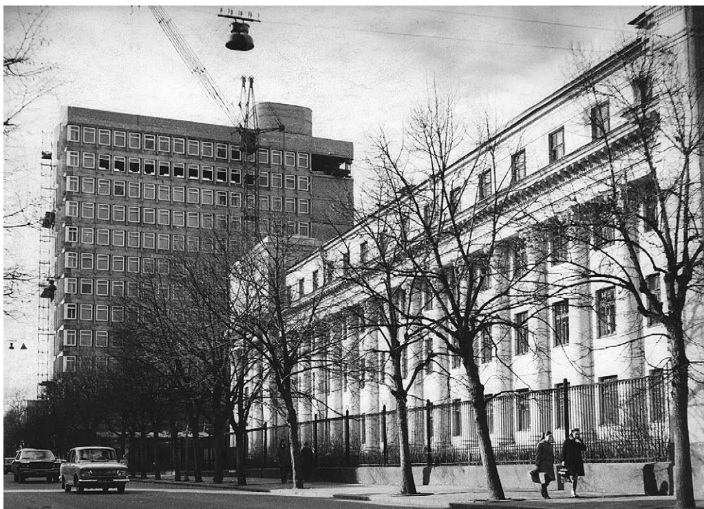
Илл. 17. Здания ГМПИ имени Гнесиных, стройка училища (1966)
